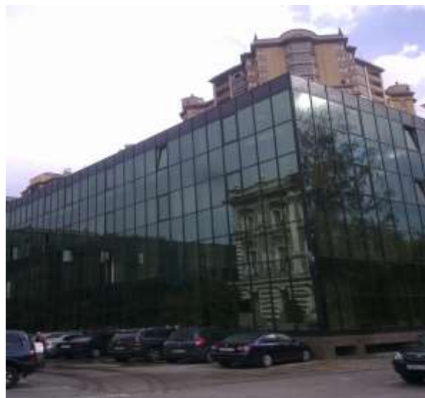
Фото.2 Нежилое здание, расположенное по адресу г. Москва, наб. ТУПОЛЕВА АКАДЕМИКА, д. 15, корп. 2
