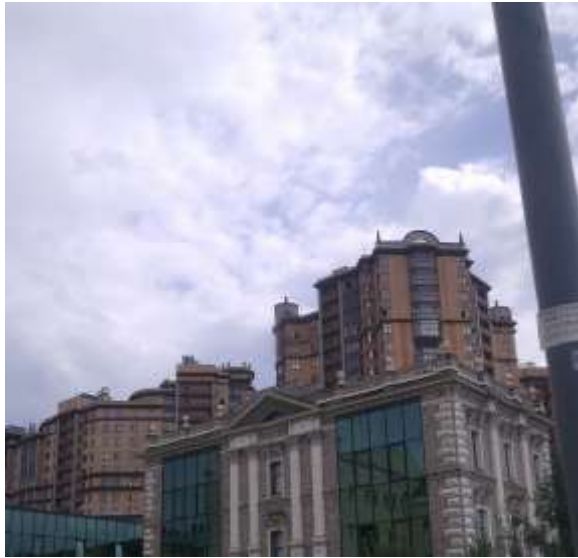
Фото1. Нежилое здание, расположенное по адресу г. Москва, наб. ТУПОЛЕВА АКАДЕМИКА, д. 15, корп. 17
