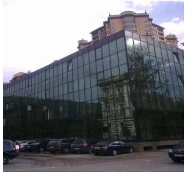
Фото.2 Нежилое здание, расположенное по адресу г. Москва, наб. ТУПОЛЕВА АКАДЕМИКА, д. 15, корп. 2
